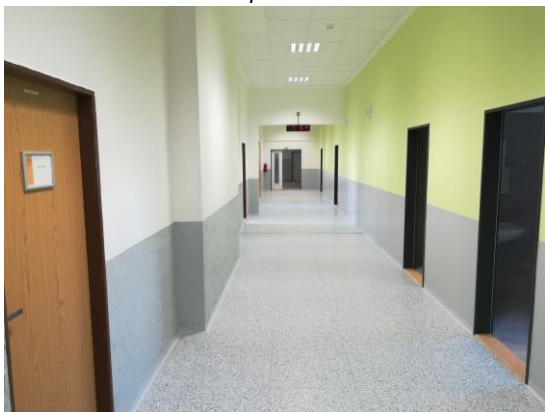
Obrázek 19-3 Hlavní budova po první etapě rekonstrukce
